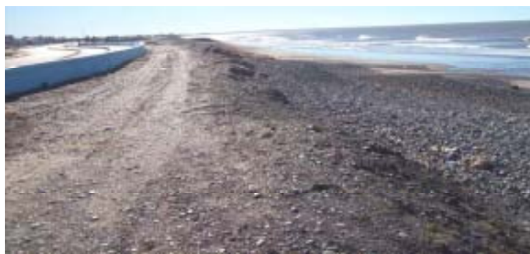
Figura 13: Erosión de la playa cerca de la escollera norte (imagen posterior al temporal de Julio de 2009)
