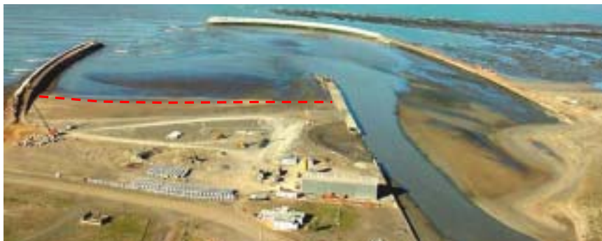
Figura 6: Aspecto de la línea de playa interna durante la construcción de las obras de abrigo
