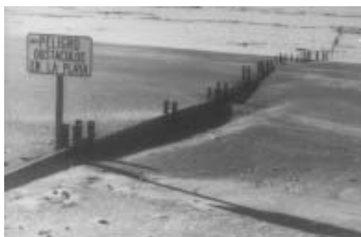
Figura 5: Barreras en la playa para atenuar los efectos erosivos (enero de 1977) (referencia 11)
