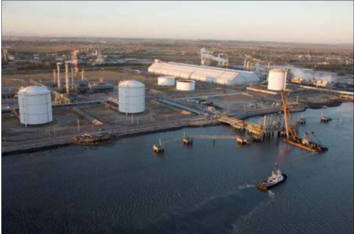
Figura 3. La Terminal Mega durante las tareas de adaptación
