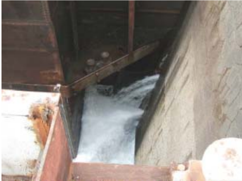
OBRA EN AREA LITORAL MARITIMO- AFECTACION DEL CIERRE DEL RECINTO.
