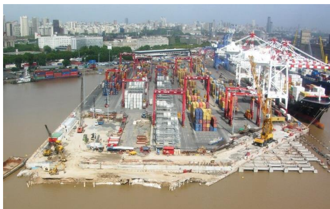
Figura 9: Vista general de la obra
