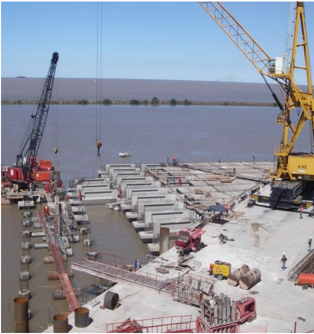
Figura 8: Montaje de elementos premoldeados
