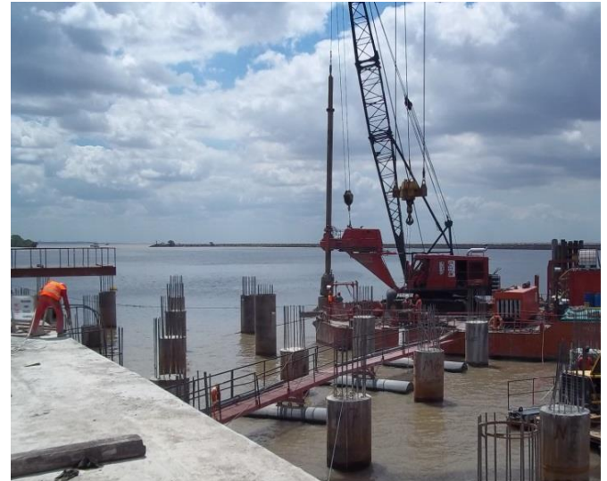
Figura 8: Ejecución de los pilotes
