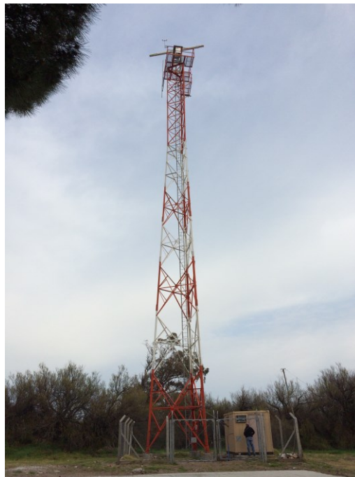
Figura 3: Torre de Radar en Baterías
