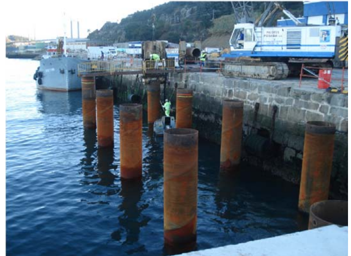
Figura 4: Imagen de las obras
