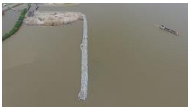
Fig. N° 15: Final de Obra.
