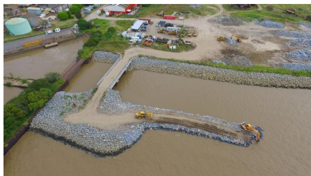
Fig. N° 14: Inicio de Obra.
