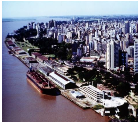
Figura 1. Fotografía de la zonal Parque de España durante su construcción.
